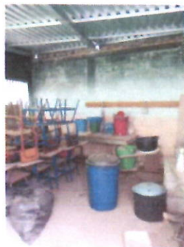
REPELLO Y CERNIDO EN PAREDES, SUSTITUCION DE REPELLO Y CERNIDO EN PAREDES EN MAL ESTADO
