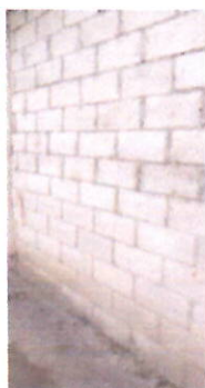
PINTURA EN MUROS EXTERIOR
